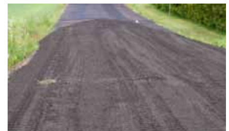
Knust asfalt i fraksjon 0-22 mm ble tilført, vannet, planert og komprimert.
