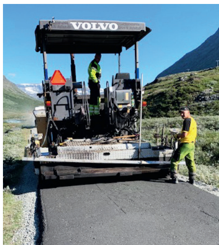
Leder ved KV Asfalt, Kjetil Villa, under utleggingen på fjellvegen.
