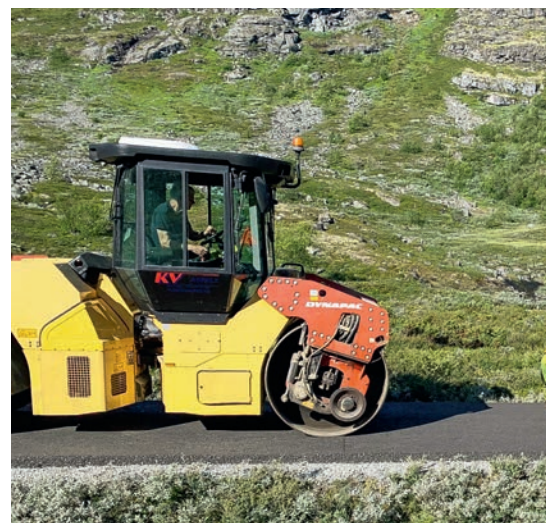
Asfaltleggingen i Leirdalen, med stor utlegger
