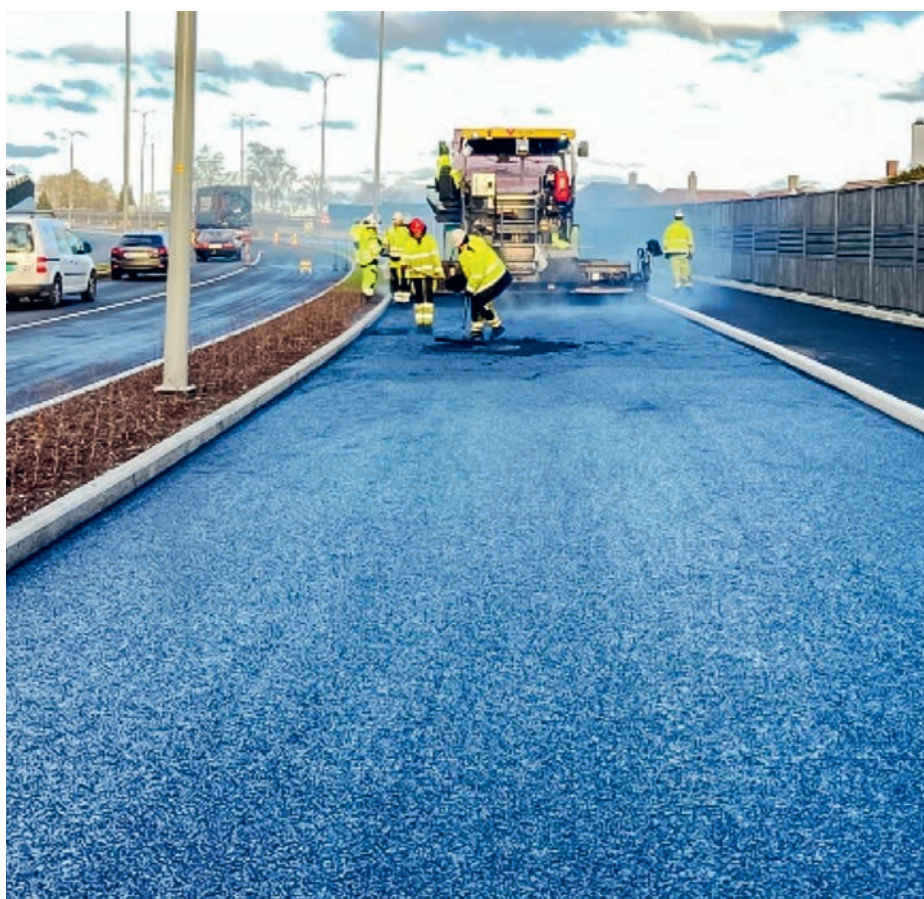
Utlegging av Ska 11 med 40 % RA.
