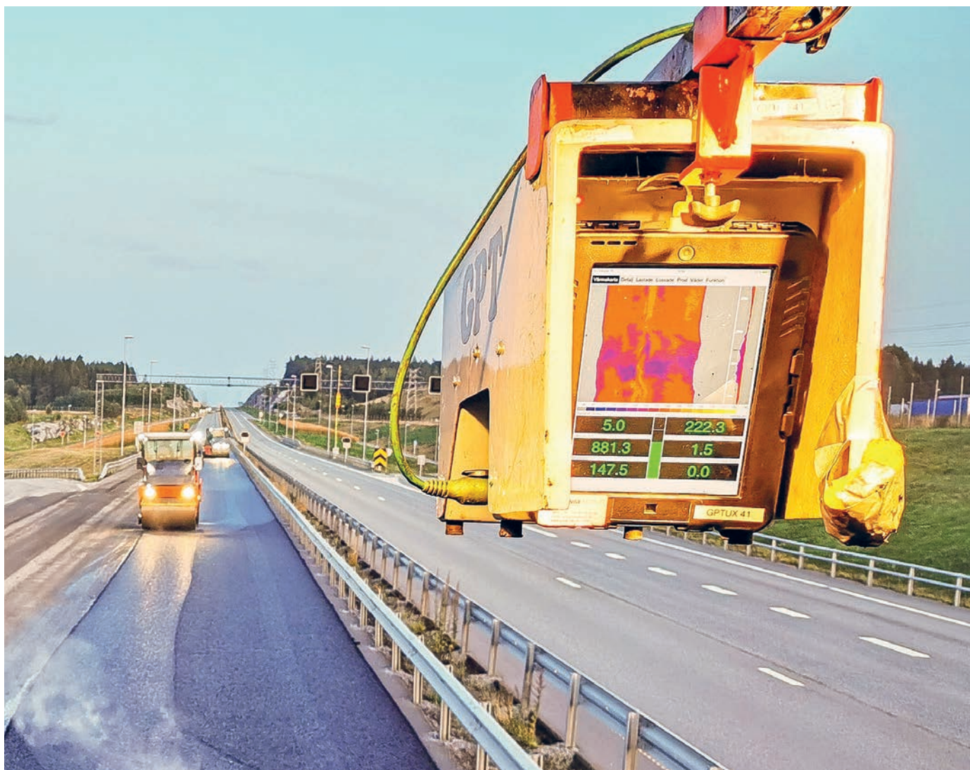
IR-skanning brukes for å kontrollere kvaliteten på gjennomføring av asfaltarbeider. Veiteknisk Institutt har utført IR-skanninger siden 2011.
