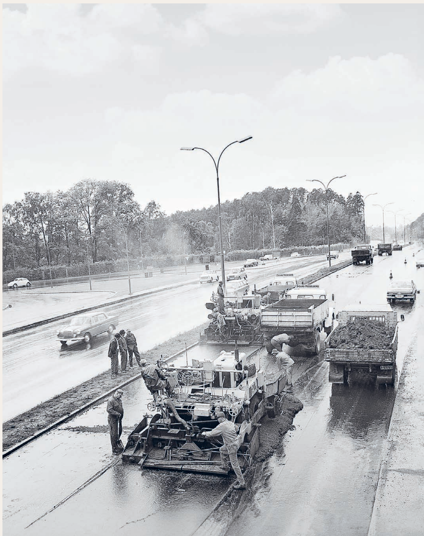
Asfaltering av Drammensveien ved Vækerø i 1970.
