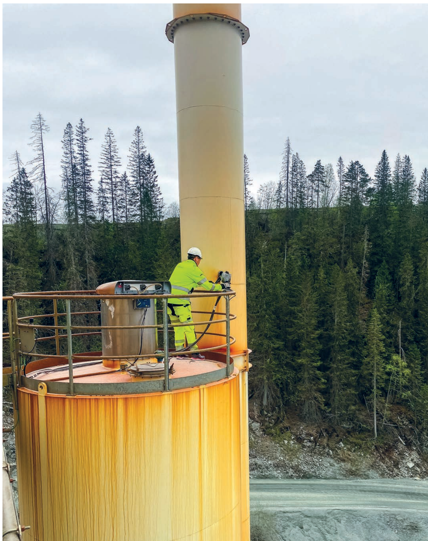
Eirik Ohma Solberg utfører støvmåling på en asfaltfabrikk i Trondheim i 2023. Sonden er plassert cirka 40 meter over bakkenivå.
