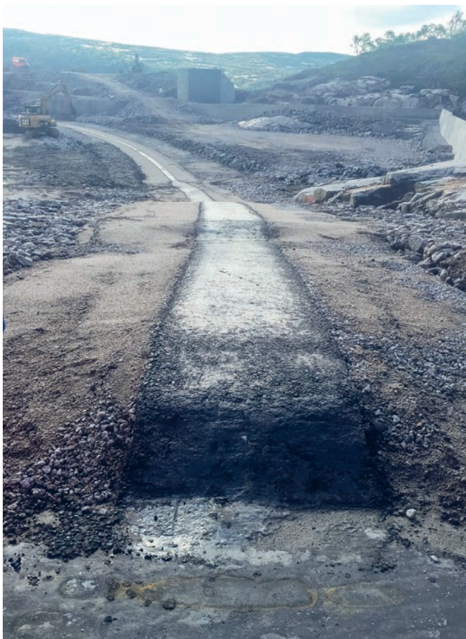
Tetningskjerne av asfalt av et damanlegg i Åseral.
