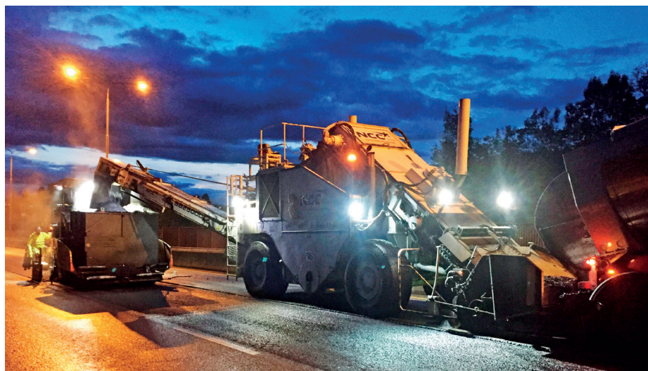
NCC legger nytt asfaltdekke på E18 i Asker.
